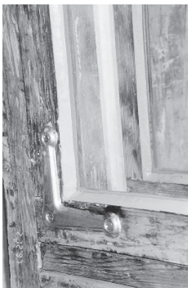
Figur 8.13 Detalj av återglasade bågar.
