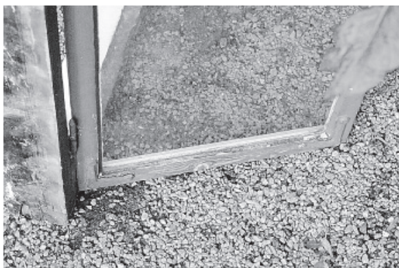
Figur 8.4 Ytterbågarna har inga rötskador.
