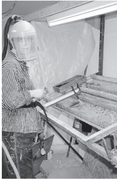
Figur 8.9 Färgborttagning med hetluft.
