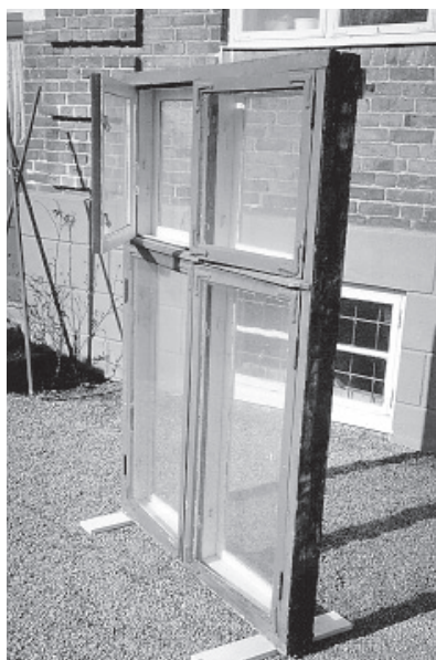
Figur 8.1 Fönster nr 1 är ett 4-luftsfönster med krysspöst och enkla yttre- och innerbågar. Tillverkningsår ca 1880.
