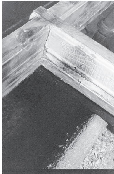
Figur 8.10 Färgborttagning med hetluft.
