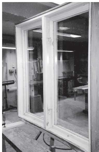
Figur 8.17 Bågarna är sidohängda i lyftgångjärn och låsta med kopparbeslag och stängda med fönsterhasp.
