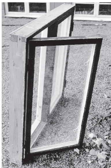
Figur 8.16 Fönster nr 2 är ett 2-lufts-fönster med mittpost och kopplade utåtgående bågar. Tillverkningsår 1930.
