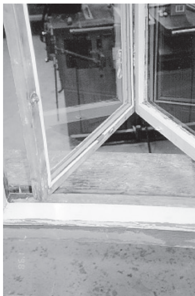
Figur 8.19 Tätning mellan bågar utfördes med slanglist av silikongummi. För ventilation mellan bågar gjordes ett 30 mm uppklipp av tätningslisten i bågens övre och undre kant. Uppklippet försågs med en dammlist.
