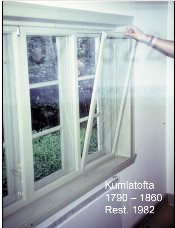
Linoljefärg insida efter 9 år Första underhåll 2010
