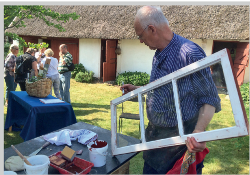
Pålssonshuset, Malmö. Pierwsza konserwacja po 30 latach.
