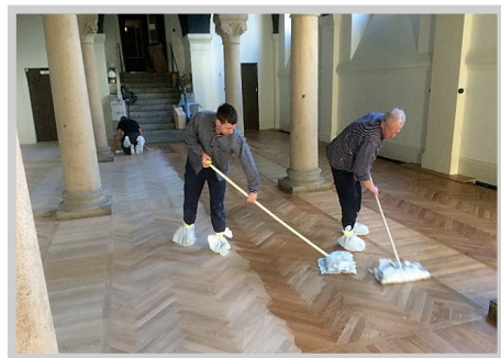
Hall uniwersytecki w Lund. Woskowanie nowej podłogi dębowej.
