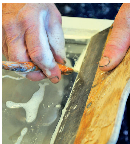
Wycinanie nadmiaru kitu z wodą z mydłem.
