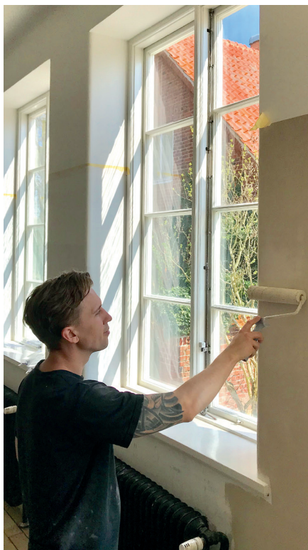
Szpachluj i maluj farbą Linus do ścian. Używaj wałka lub pędzla.
