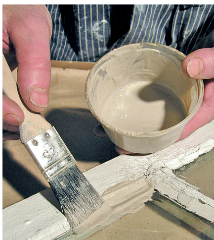
Rozcieńczony kit, metoda „opóźniająca starzenie”
