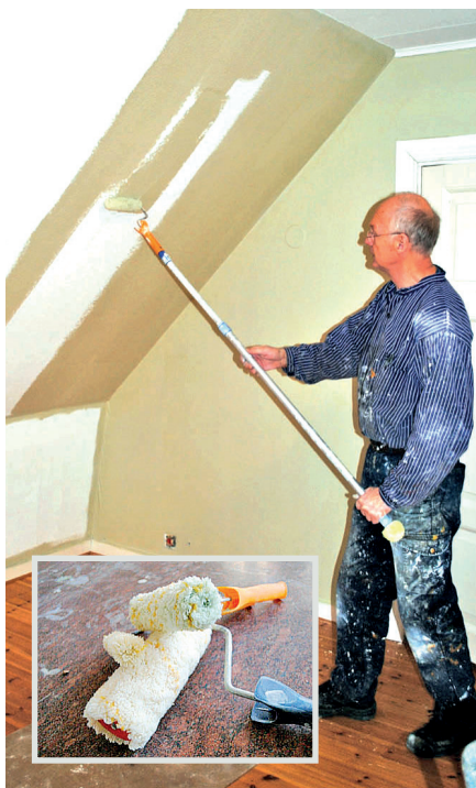
Malowanie wałkiem ścian z tapetą.
