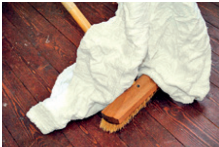
Torka bort överskottet med frottéhandduk.
