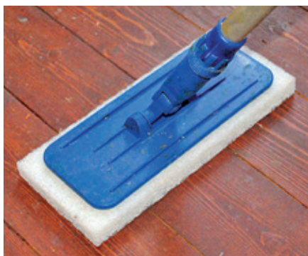
Linoljevax appliceras lätt med sträv skursvamp typ Scotch Brite.
